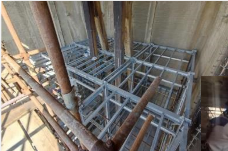
تصویر ۲۴ نصب سازه فلزی جدید داخل سازه بتنی موجود
