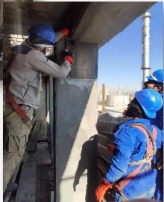
تصویر ۲۳ نصب FRP جهت تقویت ستون
