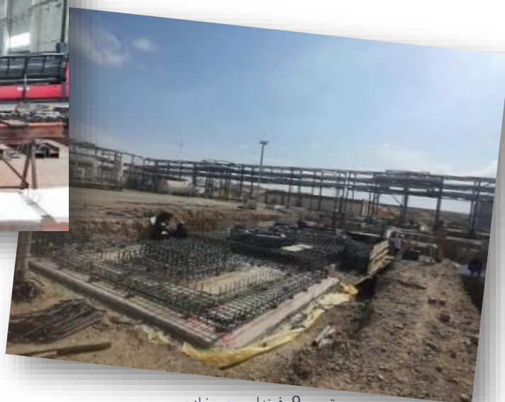
تصویر 9 فونداسیون مخازن
