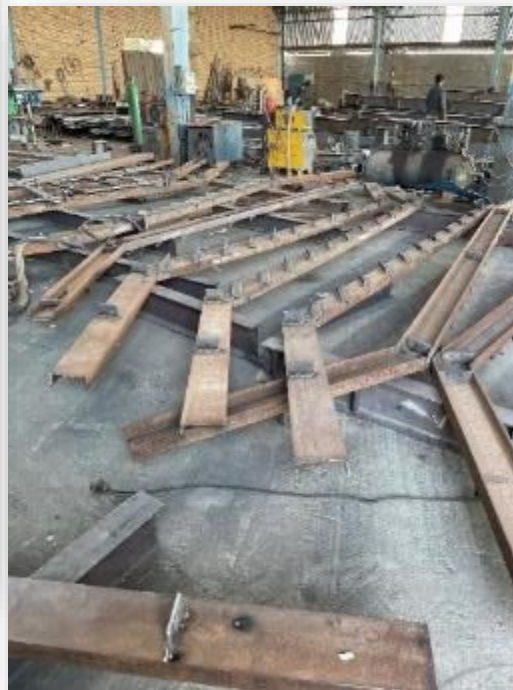
تصویر ۲۵ ساخت سازه‌های برج خنک‌کننده پتروشیمی کرمانشاه
