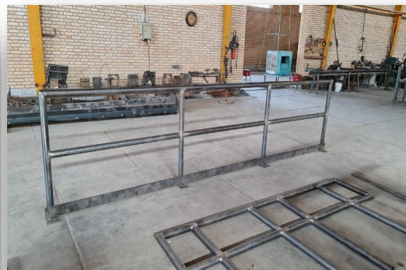
تصویر ۲۶ ساخت سازه‌های فلزی پروژه مهر پترو کیمیا
