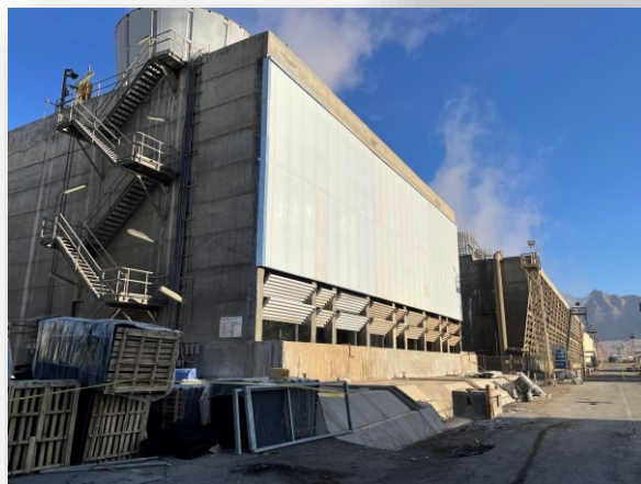
تصویر ۳۴ روند ساخت پروژه بهسازی و بهبود عملکرد برج خنک کننده شرکت نفت سپاهان
